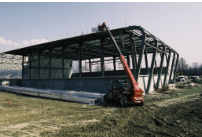
Les travaux en cours
